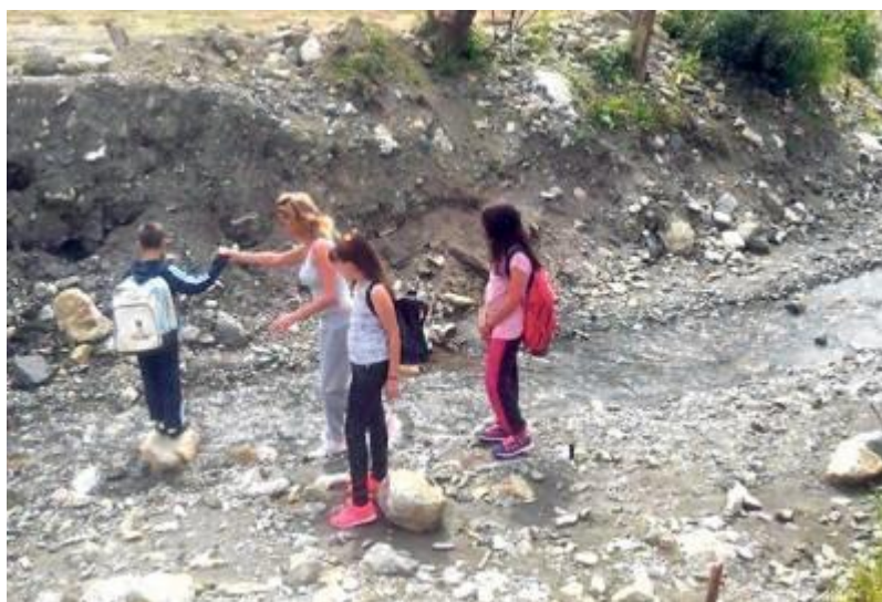
Слика 65. Горња Трешњица, прелаз преко реке услед порушеног моста, Извор www.kurir.rs
